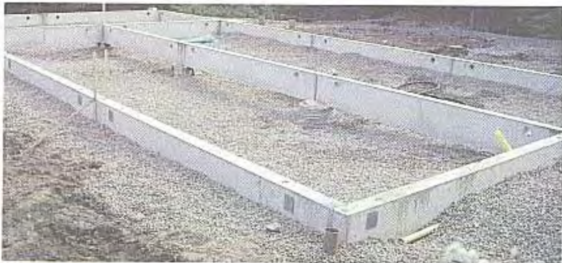
Bild 4.1.1 Kryprumsgrund vid byggnation (Hansson och Gross, 1991)
