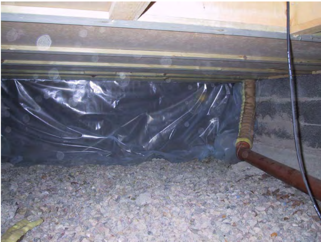
Avgränsning, 1, i kryprummet med plastfolie
