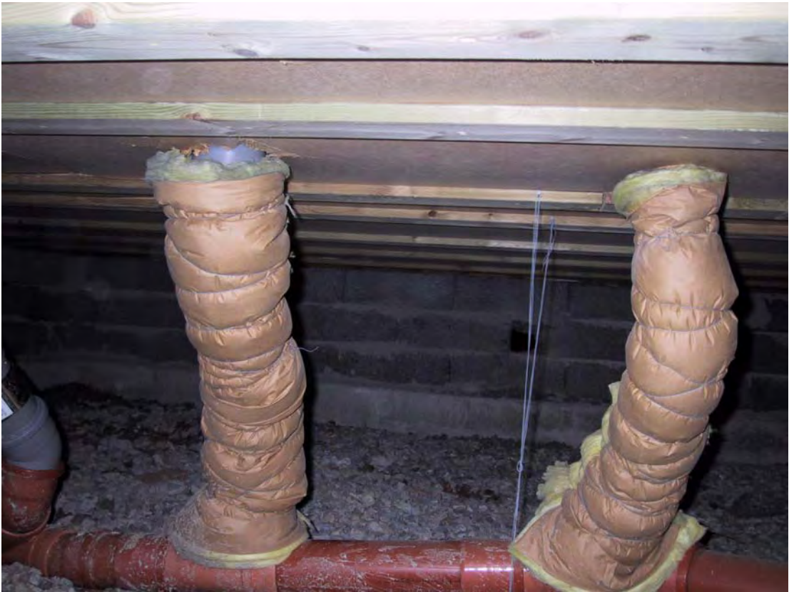
Kryrummet innan installationen av luftkuddar (avloppsrör)
